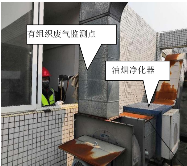
油烟净化器及有组织废气监测点
